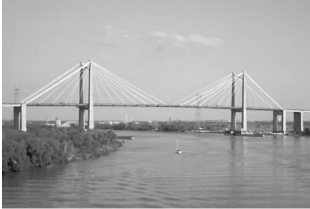
Fig. A: The Zárate Bridge
